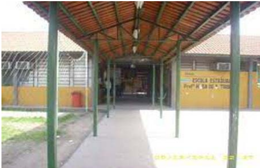
Figura 2 - Hall da escola
