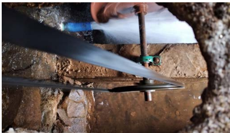
Figura 10 - Conjunto de Acoplamento Turbina Gerador
