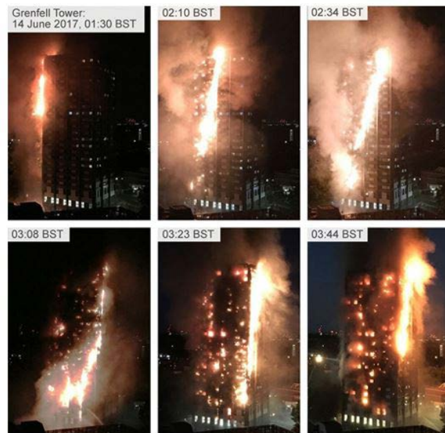
Figura 20 – Velocidade de propagação das chamas
