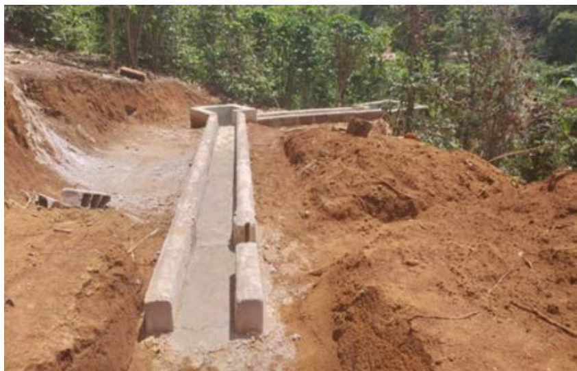
Figura 4 – Construção Canal de Adução / Caixa de Assoreamento
