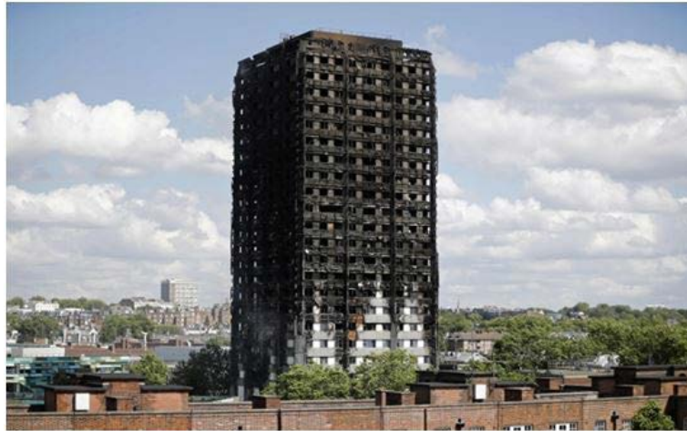
Figura 21 – Torre Grenfell após a extinção das chamas
