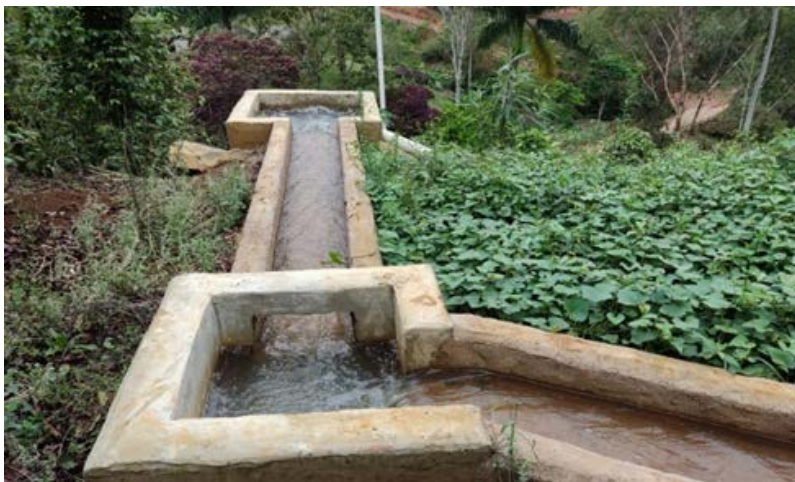
Figura 6 - Canal de Adução / Caixa de Assoreamento em Operação
