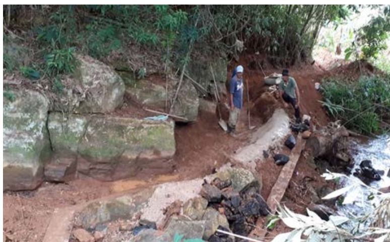
Figura 3 - Construção da Barragem
