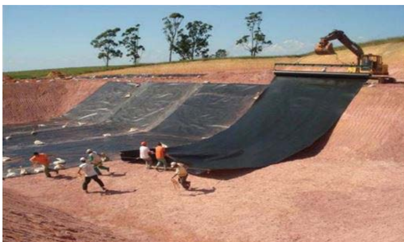
Figura 2 - Disposição das bobinas de geomembrana - Aterro sanitário de Vila Velha
