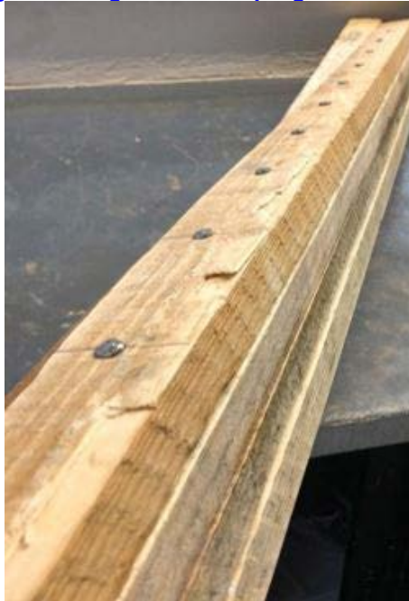
Figura 3 - Viga laminada pregada e colada.
