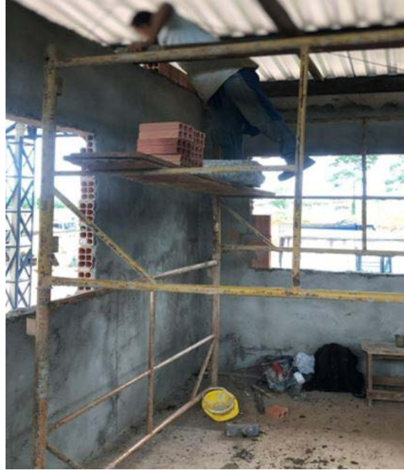
Figura 1 - Colaborador trabalhando sem proteção em ambientes de risco
