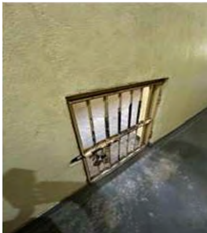
Imagem 4 – Portinhola de Acesso a Sala de Aula
