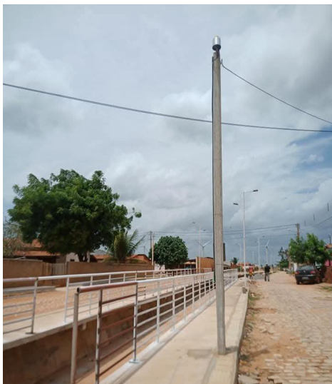
Figura 4 - A vala de Parazinho já construída, mudando a paisagem e o escoamento da água na cidade.
