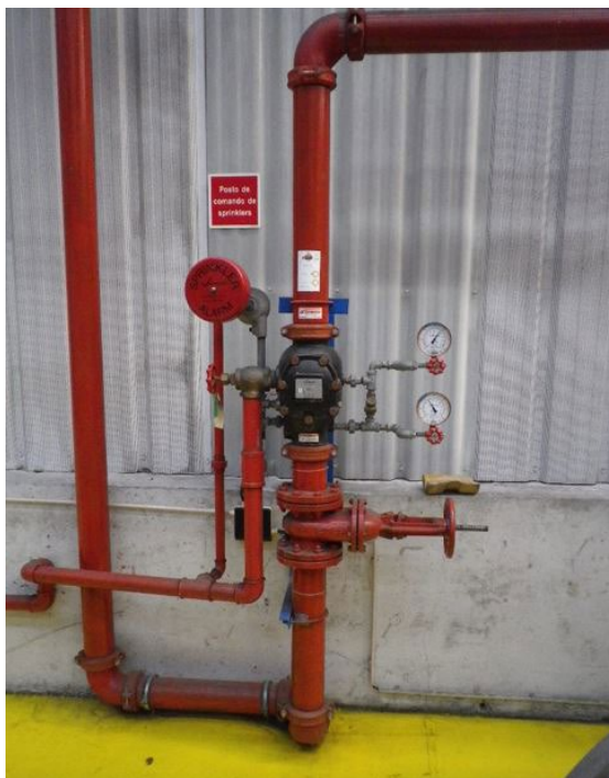
Figura 22 - Sistema de controle hidráulico de chuveiro automático.
